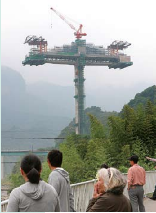
八ツ場ダムに架かる橋脚を見る観光客ら。注目度が上がり、訪れる人も多い（群馬・長野原町）
